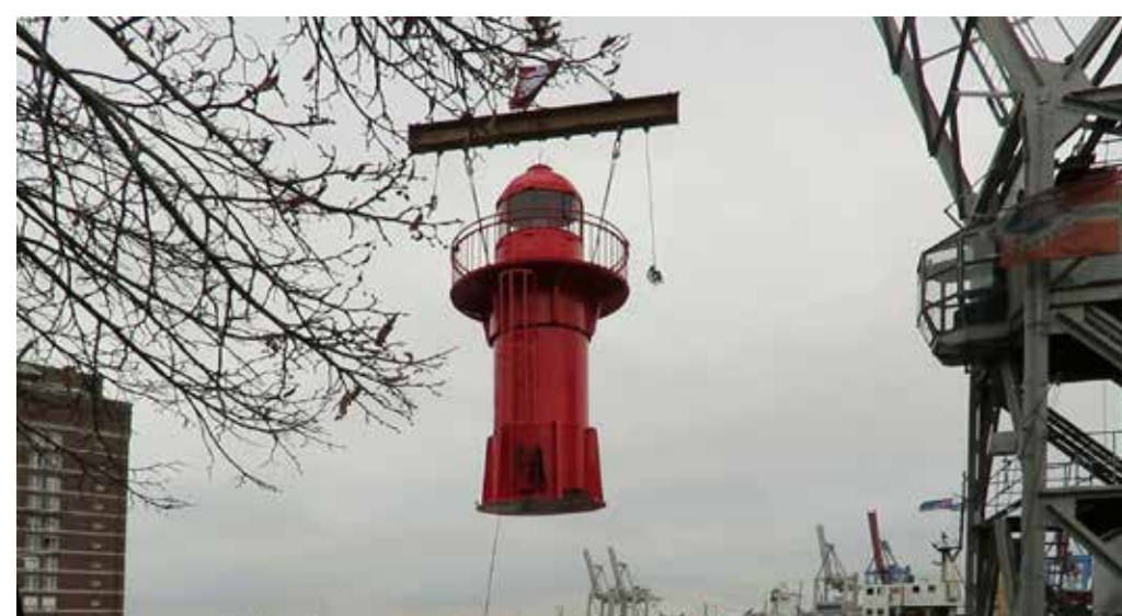
Zu Beginn der Transportprozedur hob der Schwenkran den Leuchtturmkörper erst einmal senkrecht etwa acht bis zehn Meter hoch, um ihn danach in Richtung der Altonaer Landungsbrücke zu schwenken
