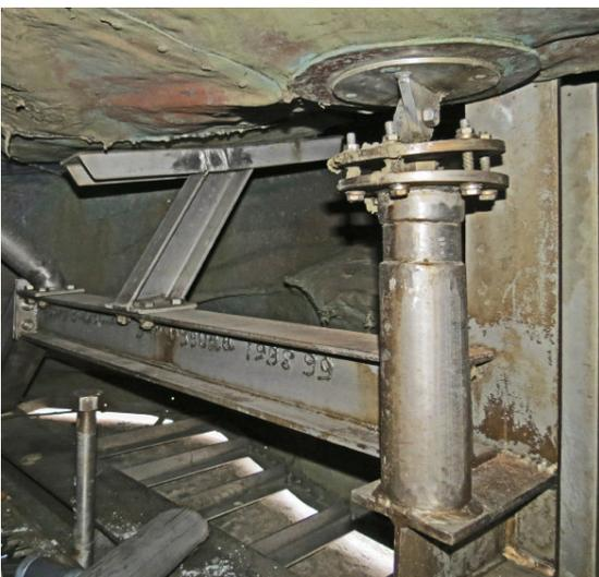
Auf der nebenstehenden Abb. ist links die eingebaute „Querstrebe“ unterhalb der Reparaturstelle zu sehen.
