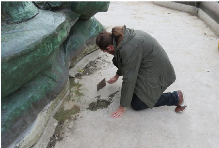
**Um den Schadensumfang im Betonrand unterhalb der Zentaurenfiguren genau feststellen zu können, legte Oliver Krafft, Student und ehrenamtlicher Mitarbeiter des Altonaer Stadtarchivs, die Reparaturstelle frei**
