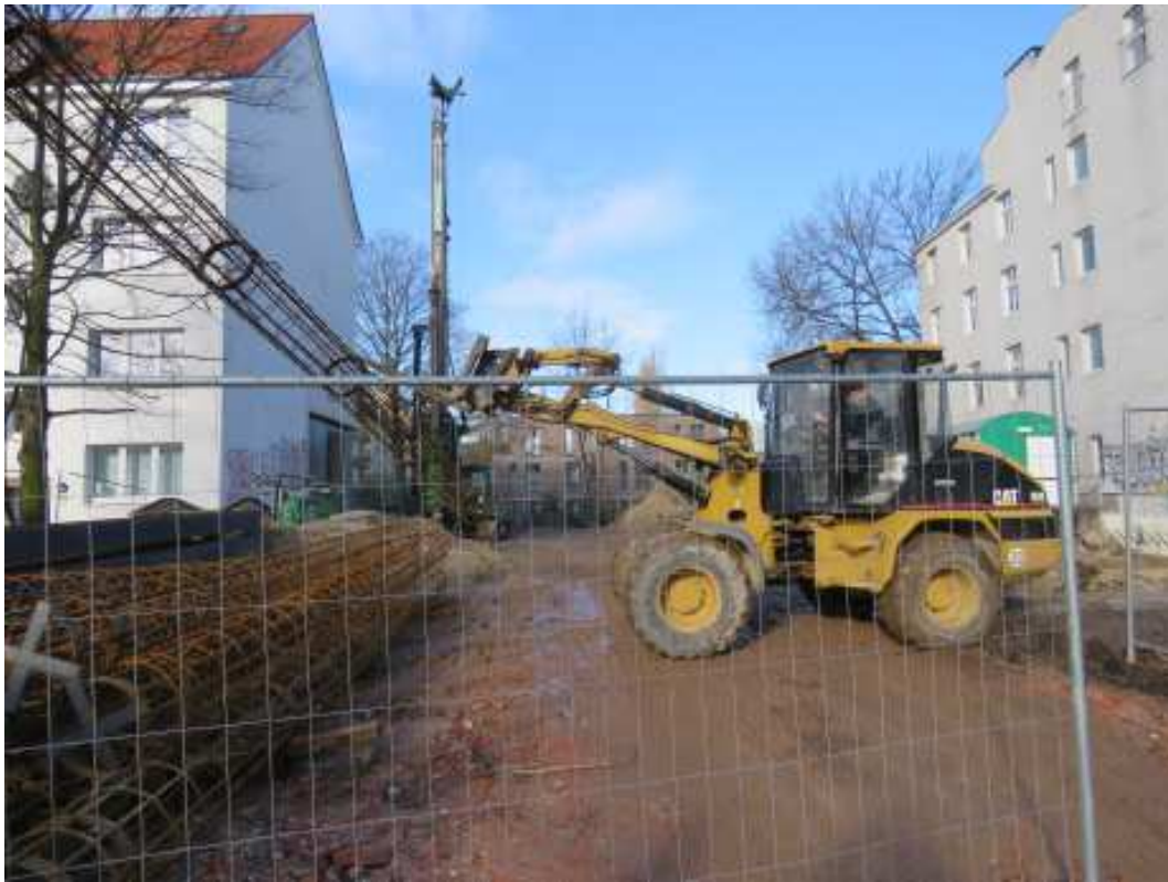
Der Bagger zieht eine leere Betonsäule hoch.
