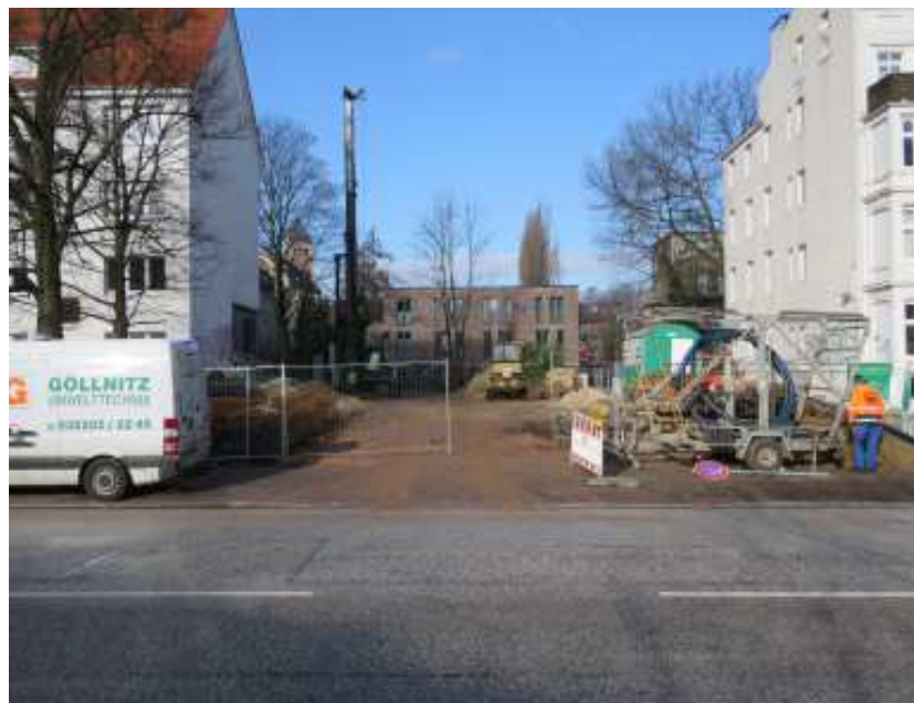
Ein Blick auf die Baustelle von der anderen Straßenseite aus.
